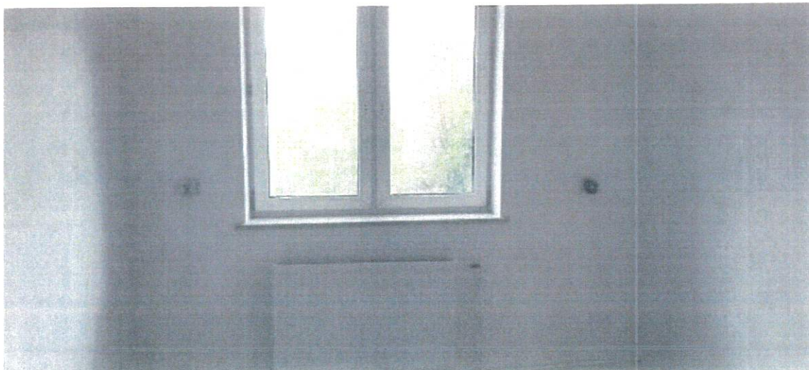
[04.05.2023 r.] Zdjęcie nr 55 | I piętro (pomieszczenia biurowe)
