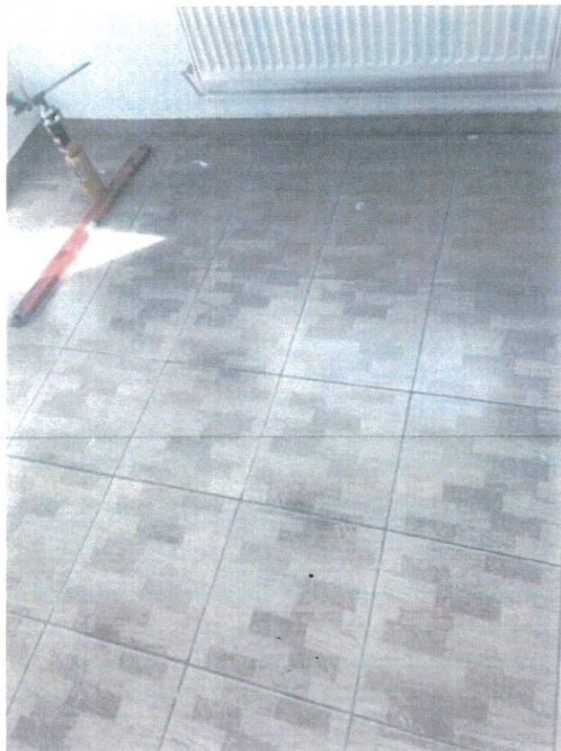
[21.04.2023 r.] Zdjęcie nr 18 | I piętro (pomieszczenia biurowe)
