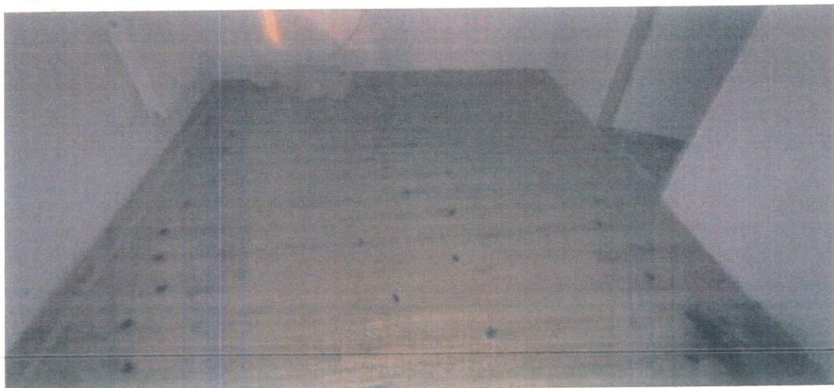
Zdjęcie nr 23 | I piętro (pomieszczenia biurowe)
